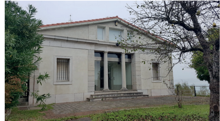
Instalaciones del Faro de la Cerda. Edificio aulario.
