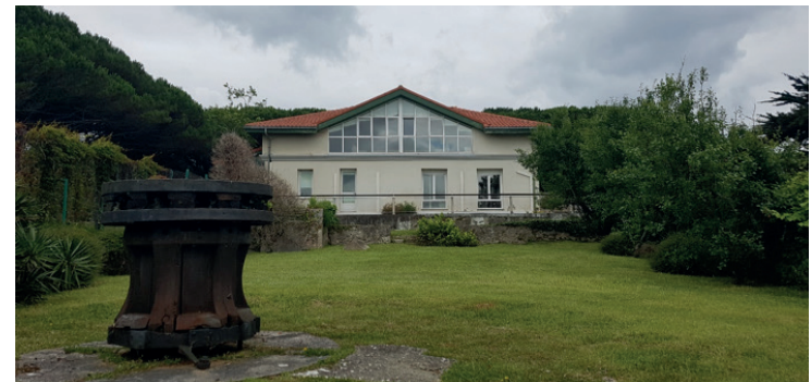
Instalaciones del Faro de la Cerda. Sede del Centro Internacional de Tecnología y Administración Portuaria.
