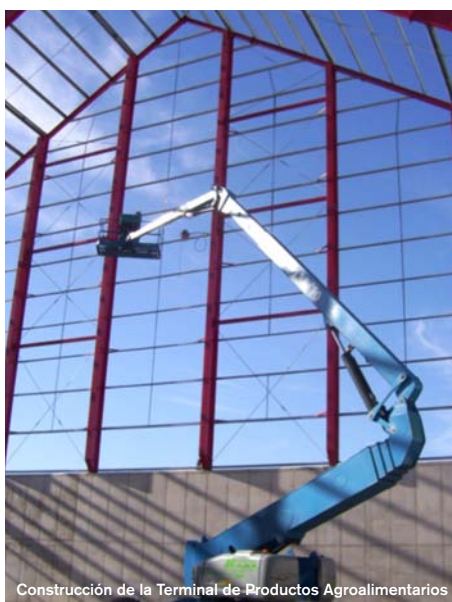
Construcción de la Terminal de Productos Agroalimentarios
