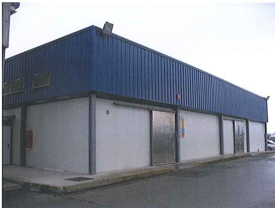
Imagen 7. Fachada de las cámaras frigoríficas
