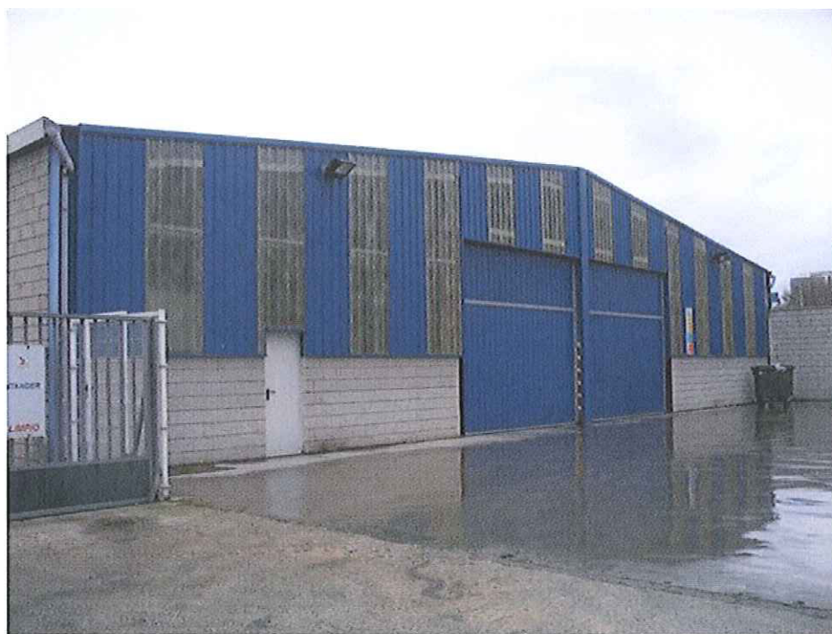
Imagen 9. Nave de limpieza de cajas
