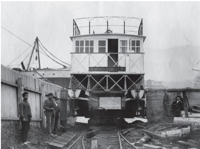
La Binave en los Astilleros Euskalduna mostrando las hélices y los timones en la popa de los dos flotadores.
