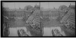
Ildefonso Rodríguez Fernández. Trabajos de construcción del Dique de Gamazo . Circa 1902.
